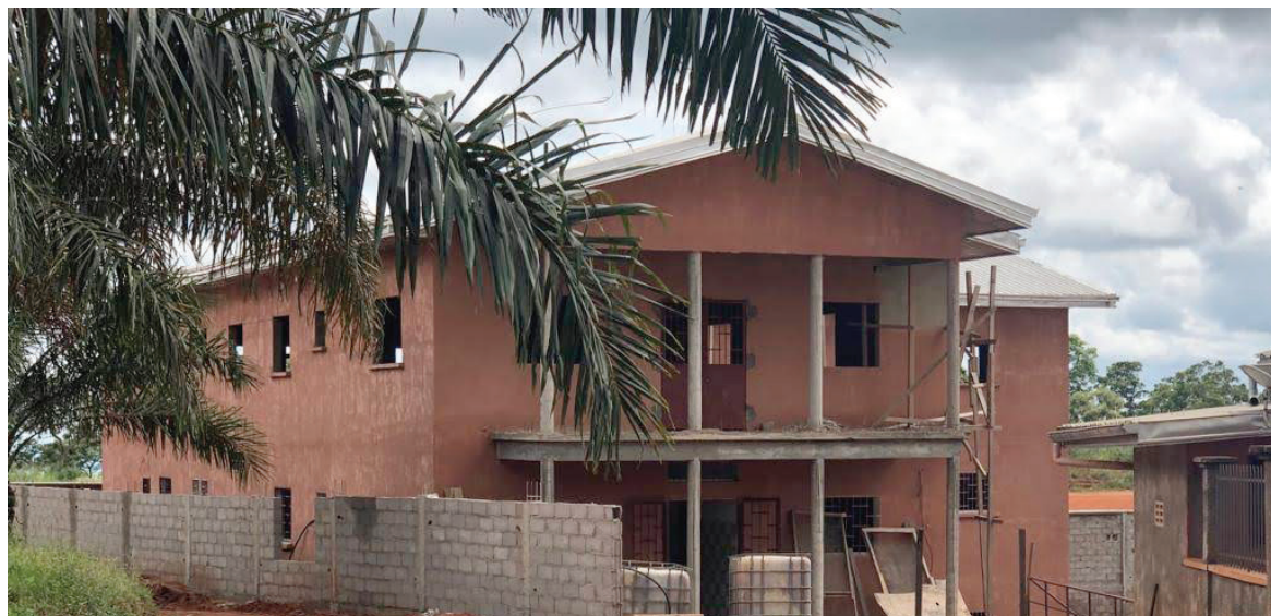
Nou edifici d'Hospitalització per al Centre Médical Catholique de Nkolondom (Camerun).
